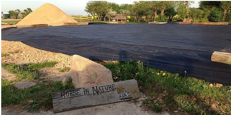
Sehr zugfeste Trennlage (siehe Höchstzugkraft) zwischen Drainageschicht und Tretschicht. Wenn Sie das PP42 mit Ankergraben als Befestigung verbauen, benötigen Sie hierfür ca. 1-2 m laufendes Gewebe (1-2 m mehr in der Länge und 1-2 m mehr in der Breite) zusätzliches Material. Auch unsere Fixierhaken sind eine sehr nützliche Befestigung außerhalb des Reitplatzes. Geht aber auch mit Holzstämmen o.ä.,
