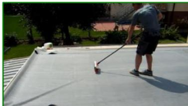
Abschließend Untergrund und Rand der Dachbahn mit Kleber einstreichen, ablüften lassen und mit einem Besen andrücken. Bevorzugt die Randbereiche im Kontaktklebeverfahren verkleben.
