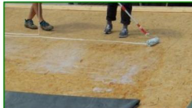
Dachbahn auf die mit Kleber eingestrichene Fläche zurückschlagen und mit einem Besen andrücken. Ebenso mit der zweiten Hälfte der Dachbahn verfahren.
